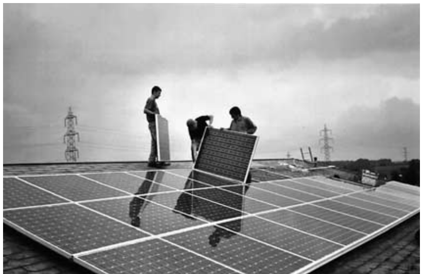
Modulmontage (Photovoltaikanlage mit 4,8 kWp Leistung) auf dem Schulhaus «Konstanzmatte» in Rothenburg, LU (Solarpreis 2002).
